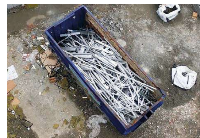
Pour clore la boucle du recyclage, Wicona a notamment mis sur la récupération de menuiseries aluminium en fin de vie sur des chantiers de rénovation.
